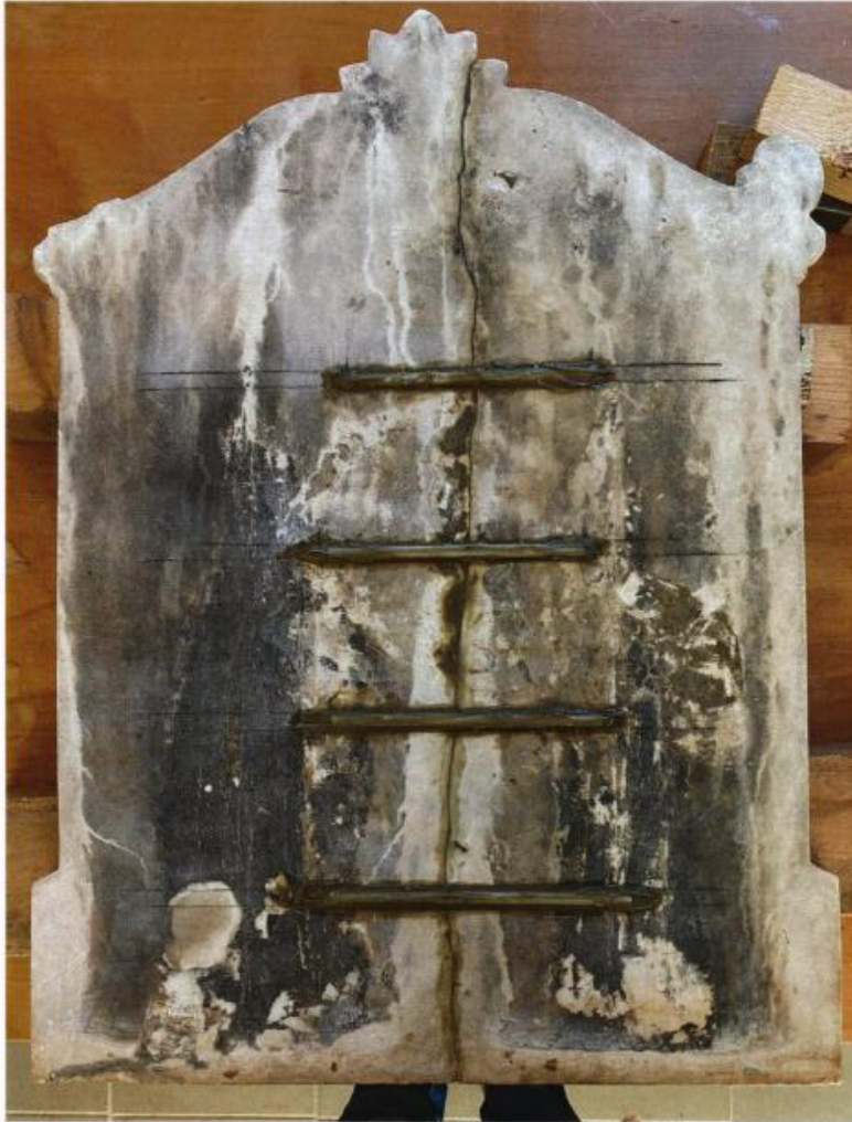
Dateiname: IMG_2708.jpg Rückseite mit 4 Dübeln aus Glasfaserverbundwerkstoff (Durchmesser 8 mm) verstärkt und mit Epoxidharz eingeklebt
